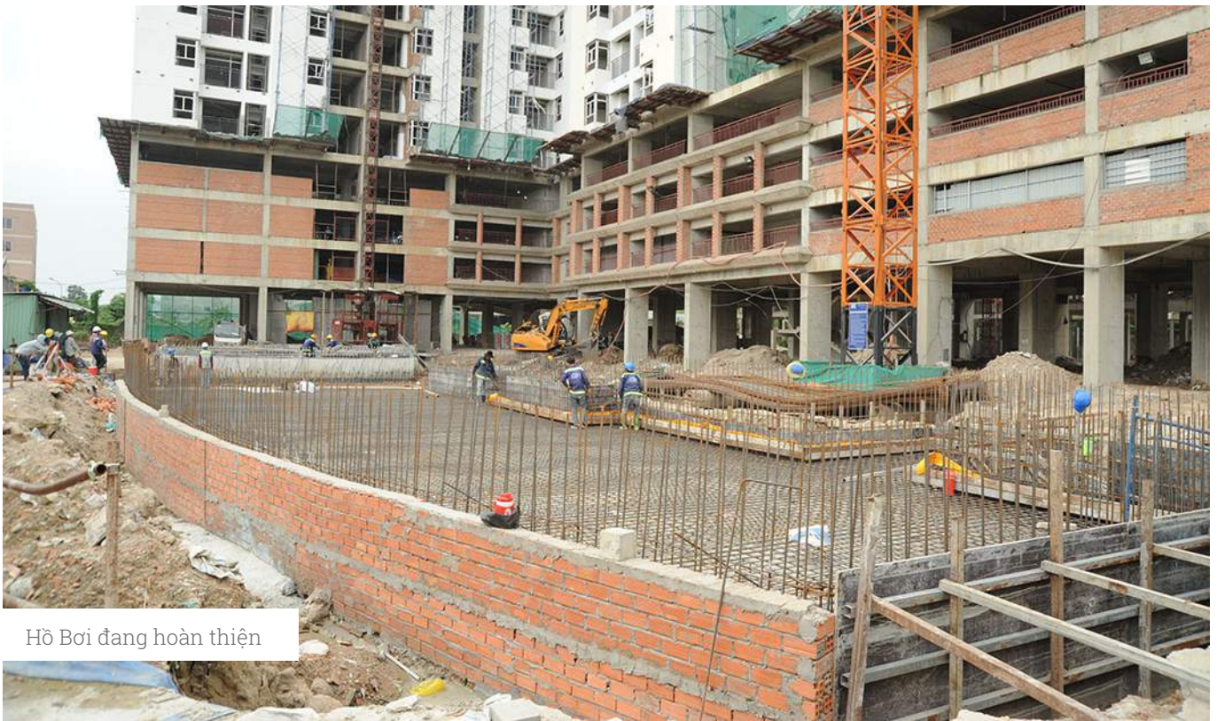
Căn hộ đang hoàn thiện
