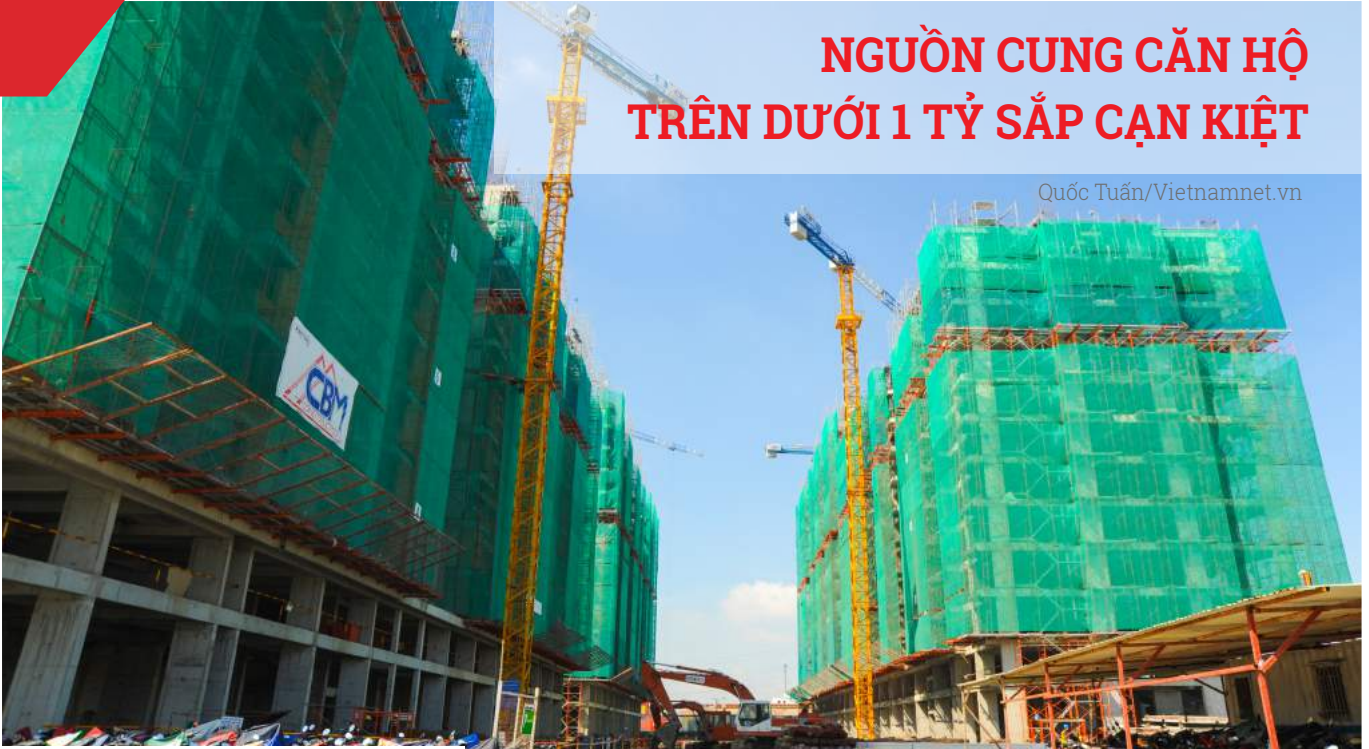
Dự án Him Lam Phú An, Quận 9 đã cất nóc nhưng chỉ thanh toán 30% là được nhận nhà.
